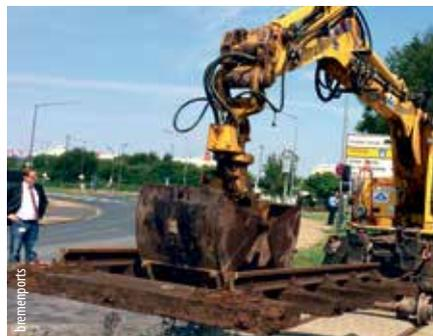
Die bremischen Häfen investierten in den Ausbau der Eisenbahnanlagen. Am **Kaiserhafen** in Bremerhaven wurden 12 von 16 Gleisen für 8,2 Millionen Euro auf bis zu 750 Meter Länge gestreckt.
